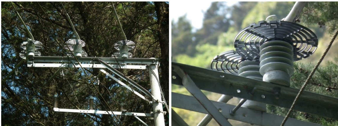
Figura 13. Dispositivo electroestático, diseño y forma correcta de colocar (imágenes fuente CNFL).
