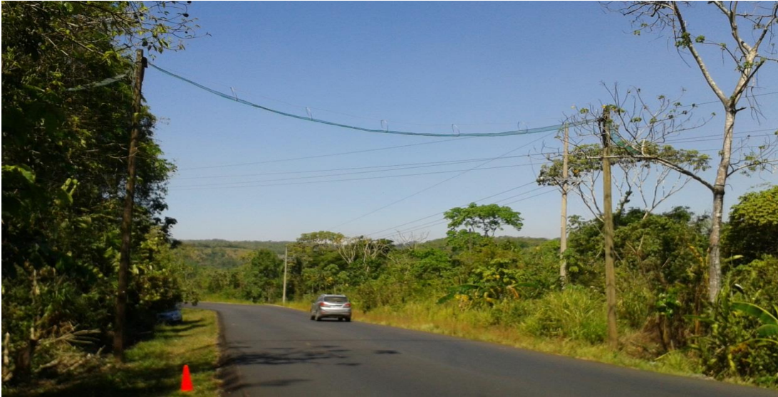
Figura 20. Pasos de fauna arbórea; diferentes diseños colocados y utilizados por fauna arbórea (Imágenes ICE y CNFL).
